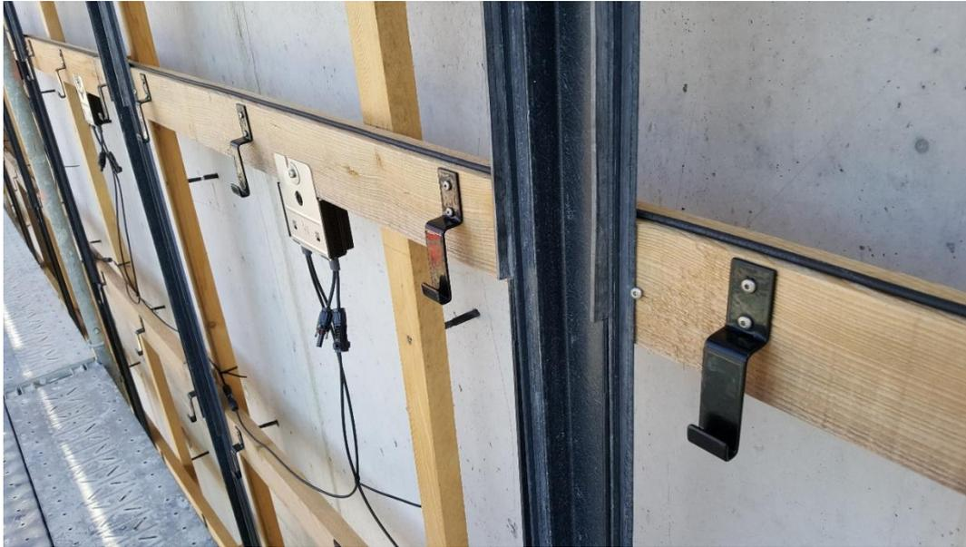
Sicherstellen, dass die Befestigung auf die UK1 oder Fassade die Kräfte aufnehmen kann
